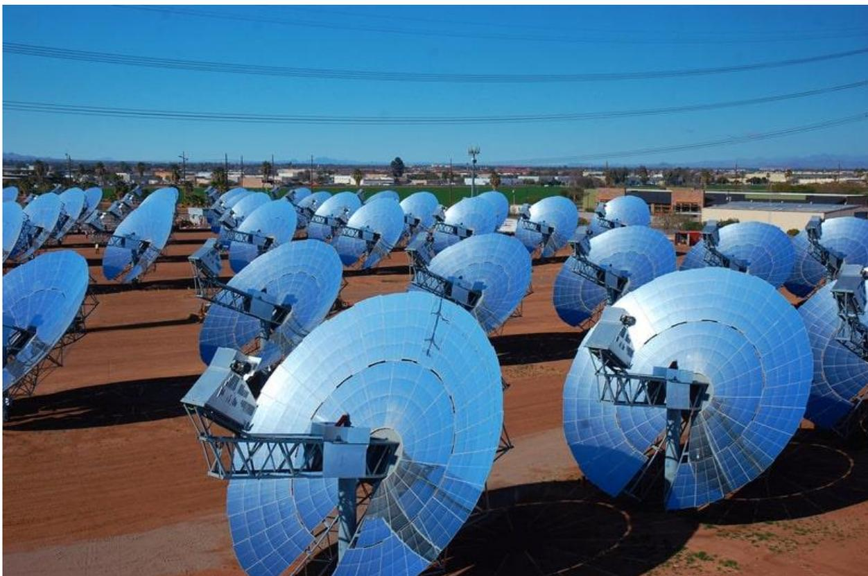
Рисунок 40 - Солнечные электростанции тарельчатого (дискового) типа
