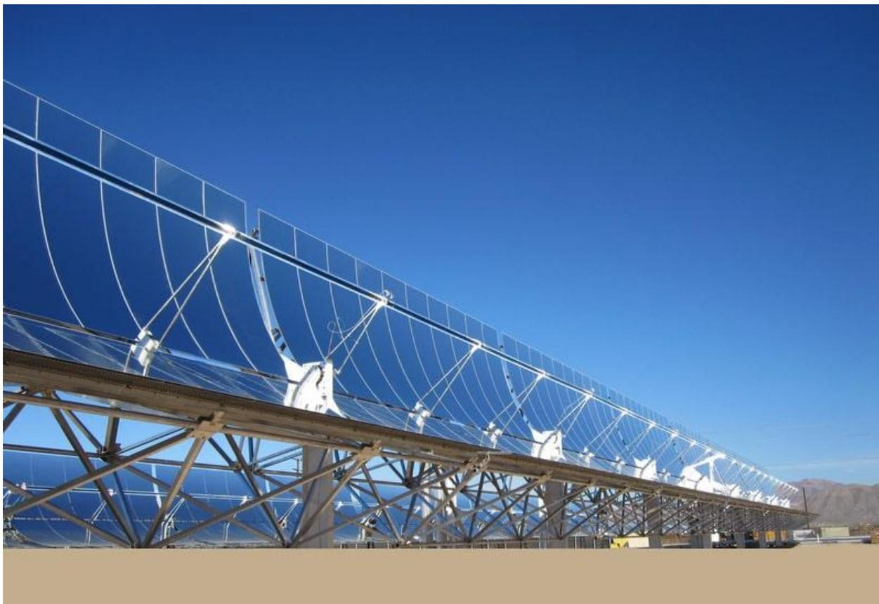
Рисунок 42 - Солнечные электростанции (СЭС) параболоцилиндрического типа
