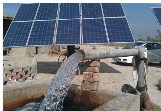
Рисунок 3.4 – Использование солнечных батарей для обеспечения работы скважин.
