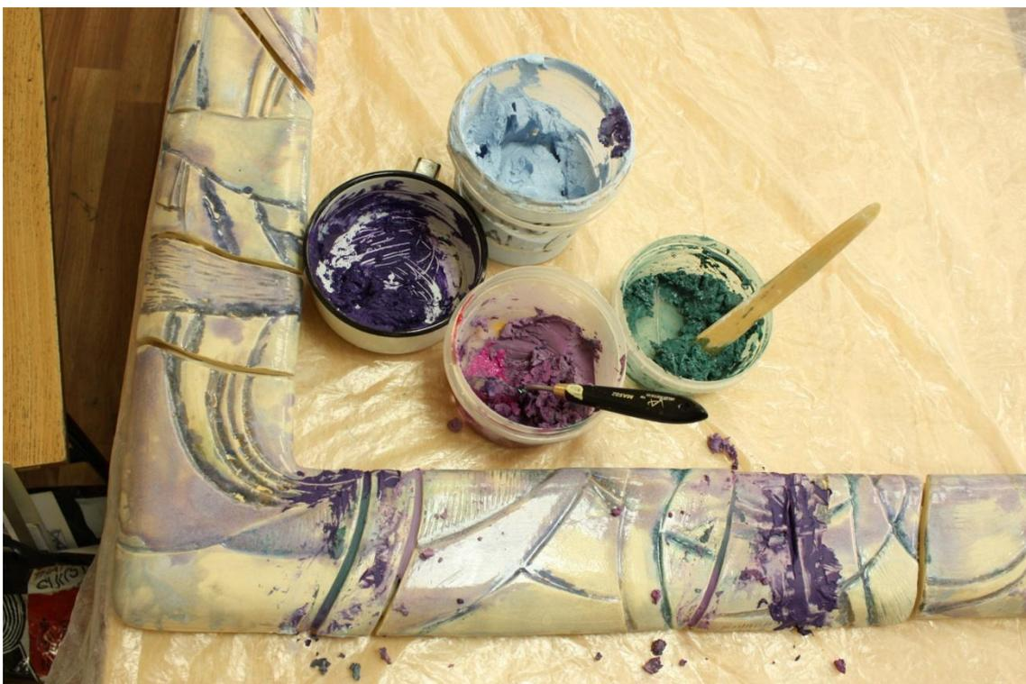
Рис. 37 Многоцветная затирка швов
