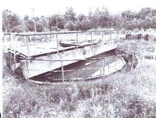
Рисунок 13. – а) - Первичные отстойники распределительный лоток; б) - Поток ст. воды на один из первичных отстойников; в) - Здание хим. лаб., КНС; г) - КНС
