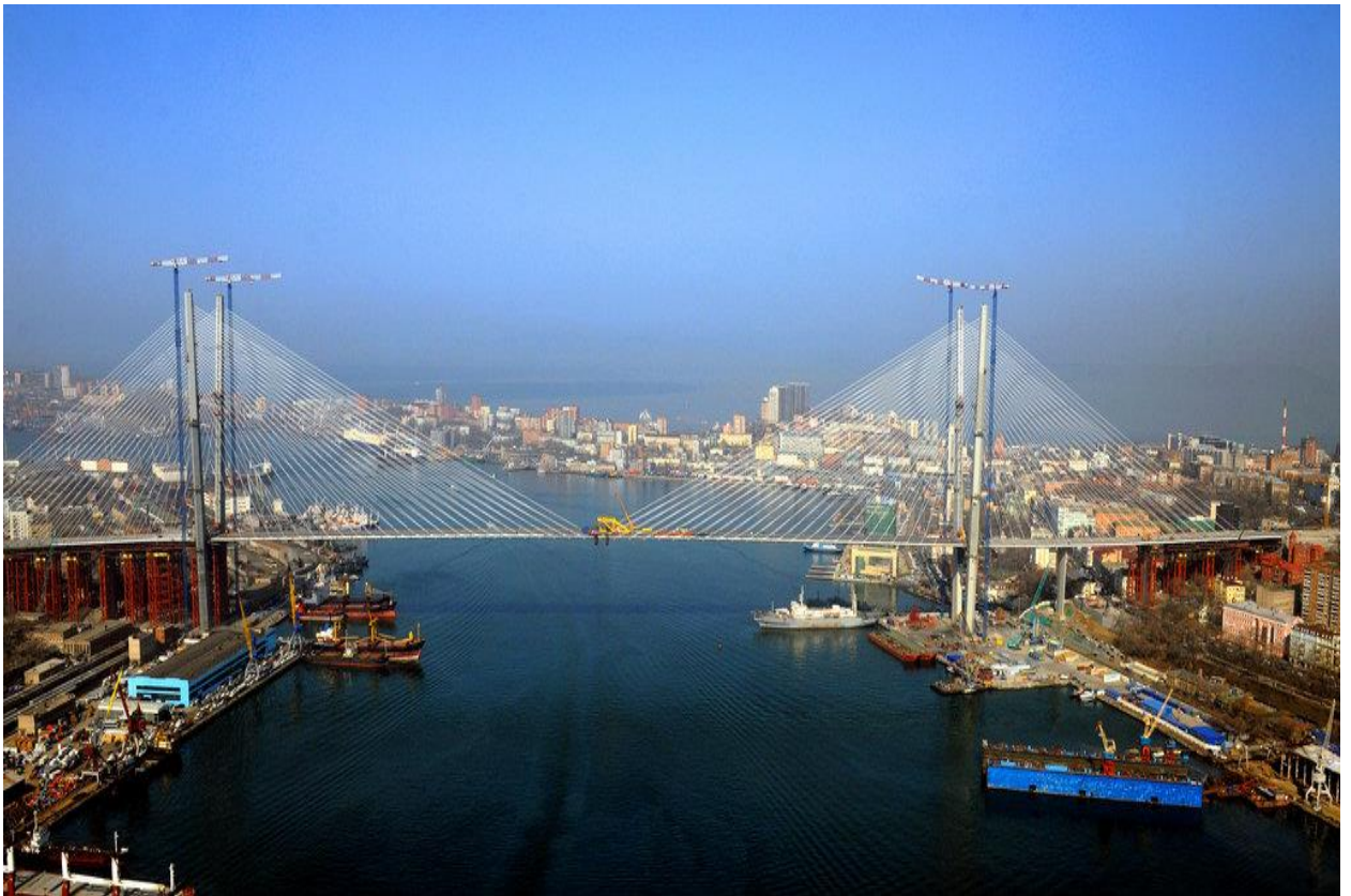
Рисунок 1.5 – Мост через бухту Золотой Рог
