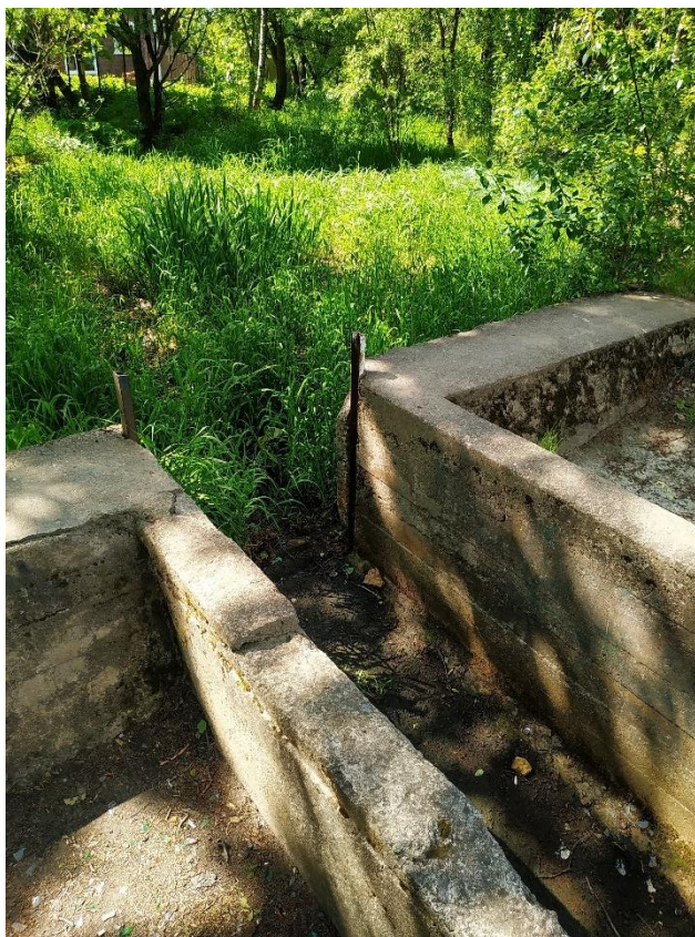
Рисунок 29 – Быстроток на проектируемом участке Лиговского канала
