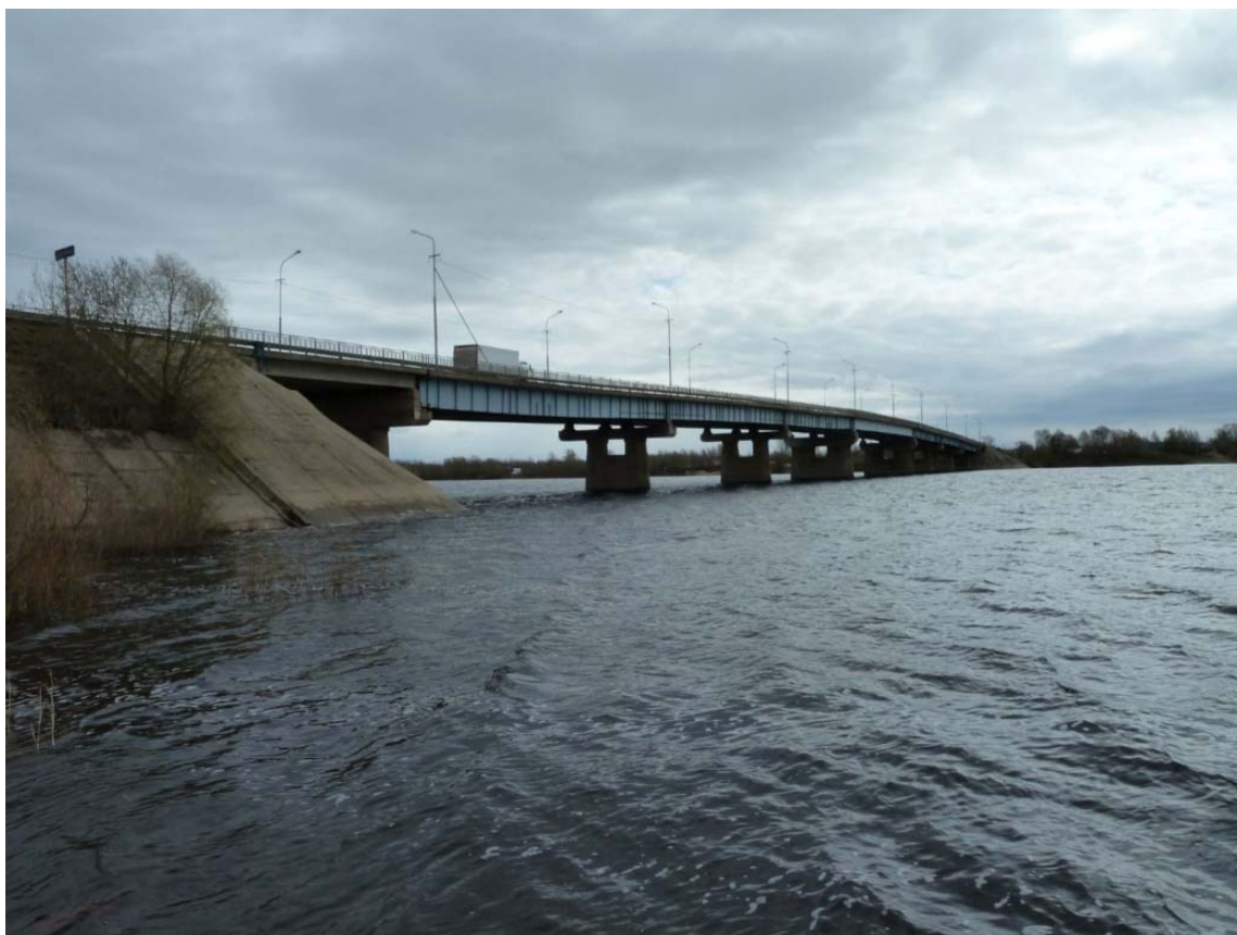
Рисунок 9. Вид с левого берега на мост через р. Шелонь
