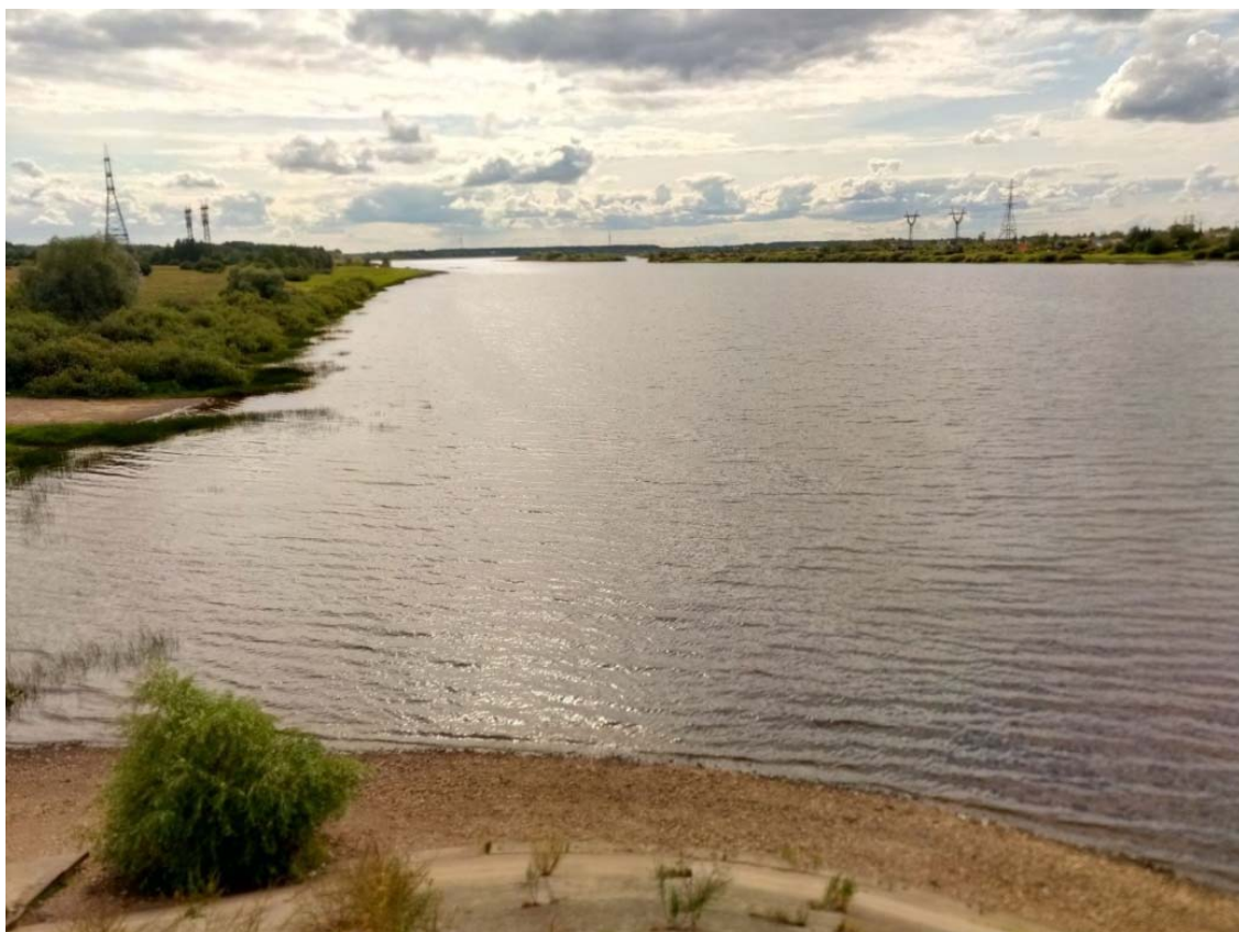
Рисунок 10. Вид с правого берега с насыпи моста вверх по течению р. Шелонь
