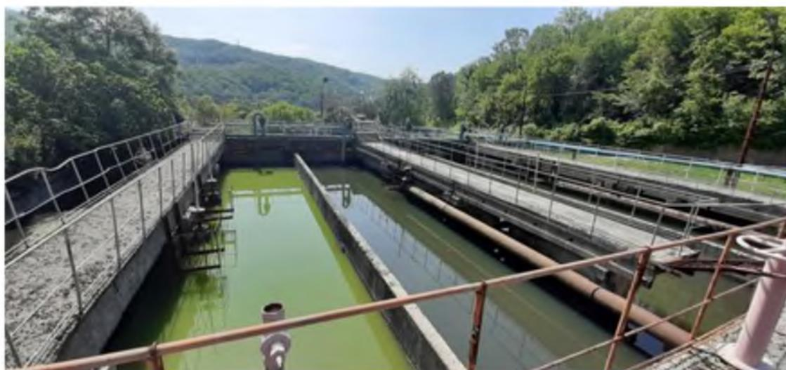
Рисунок 2.7 – Поступление стоков на биологическую очистку в аэротенки
