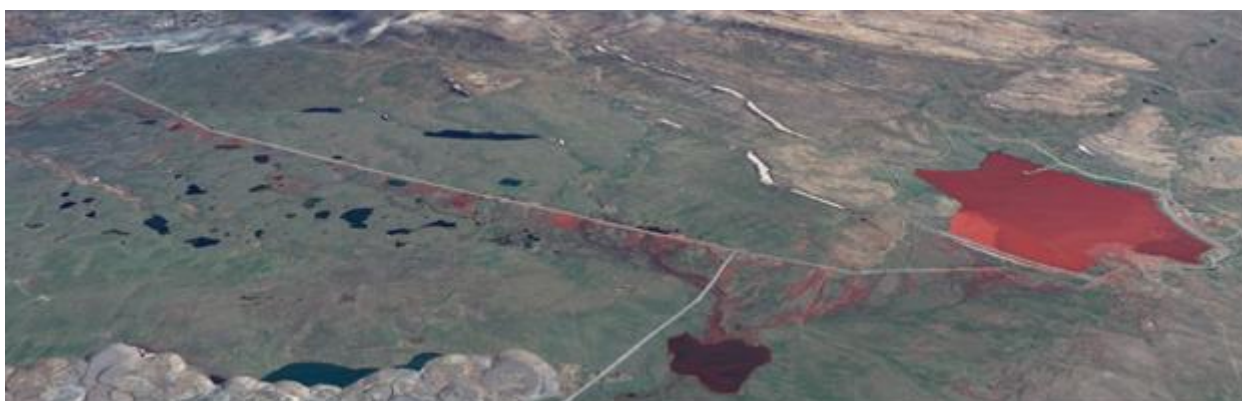
Рисунок 5.7 – Шламохранилище №1 с подводным пульпопроводом.
