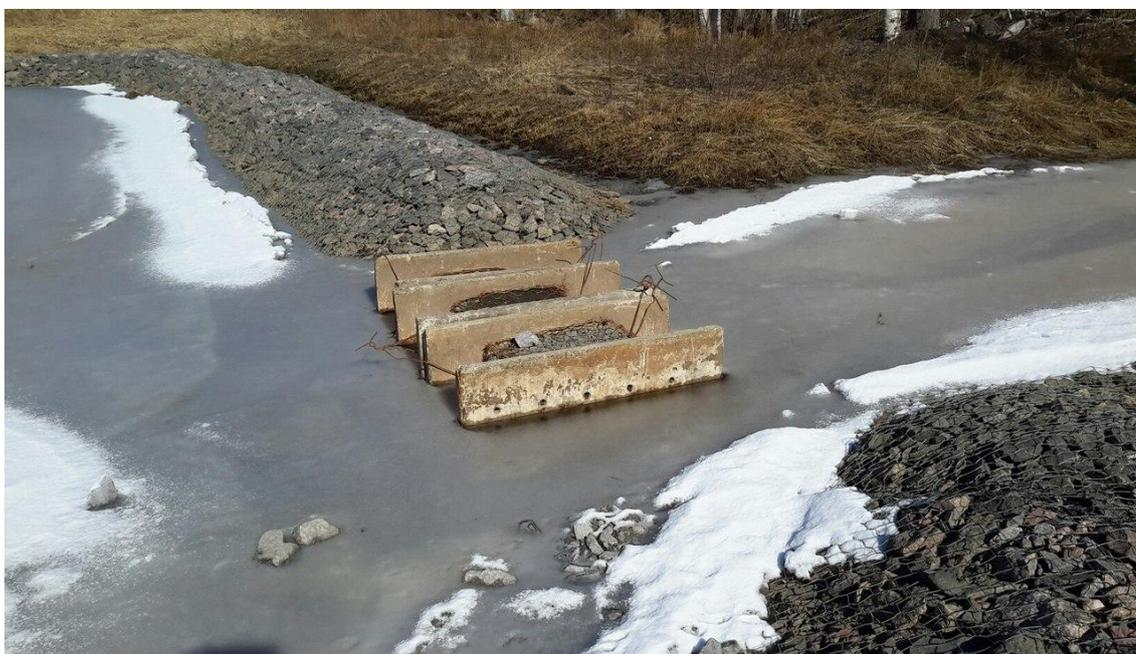
Рисунок 38 – Неэффективный фильтр взвешенных частиц и нефтепродуктов на выходе с гидробиотанической площадки ЗСД в марте 2017 года.
