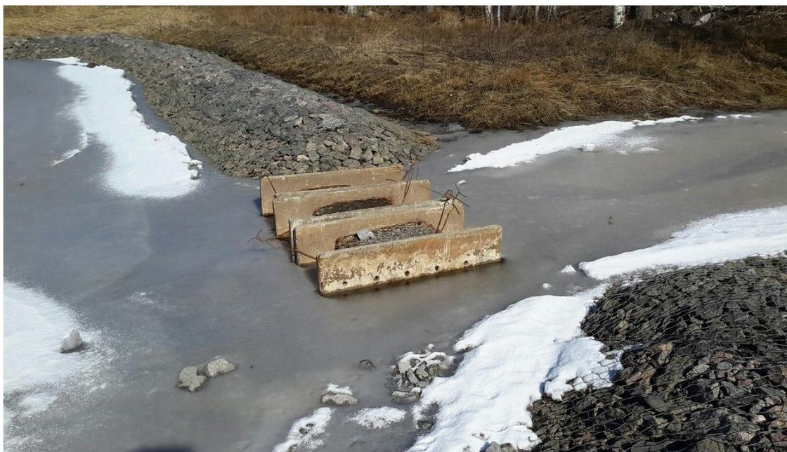
Рисунок 22 – Фильтр ГБП в месте выпуска сточной воды в дренажный канал (т. К-4)
