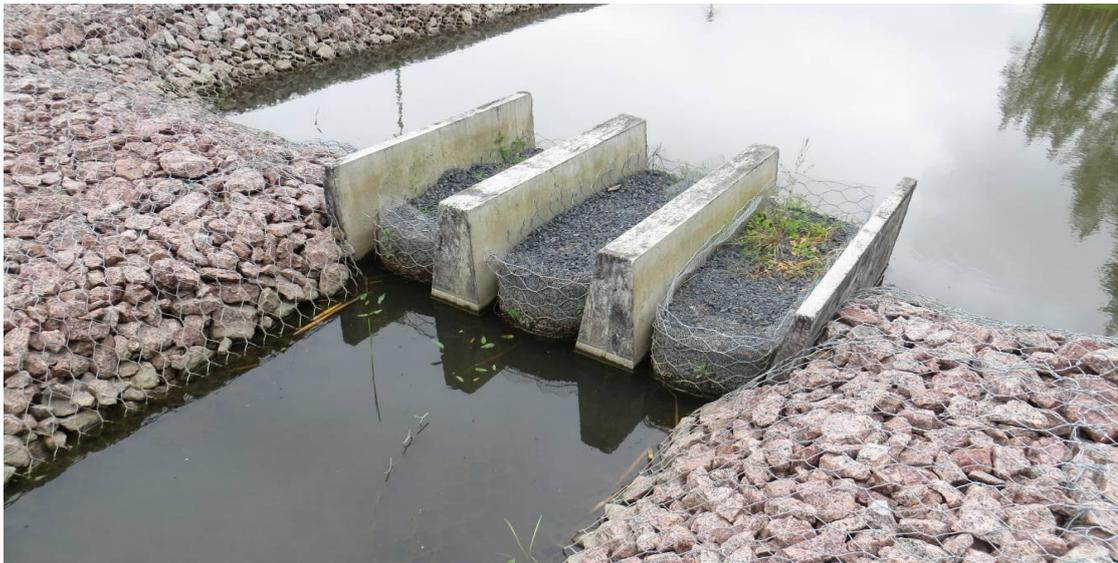
Рисунок 4 – ГБП. Фильтрующая кассета с загрузкой природным сорбентом
