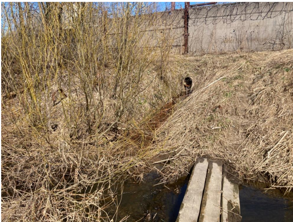
Рисунок 2.2.1 – Выпуск №3, выпуск ливневой канализации в безымянный ручей, 200 метров от устья (фото из архива автора)
