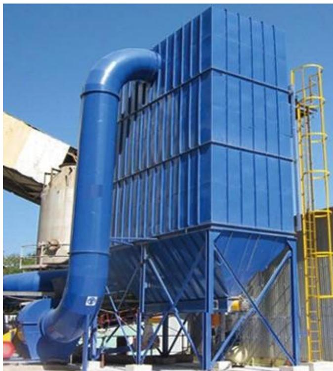
Рукавной фильтр ФРИ-630 с импульсной системой регенерации
