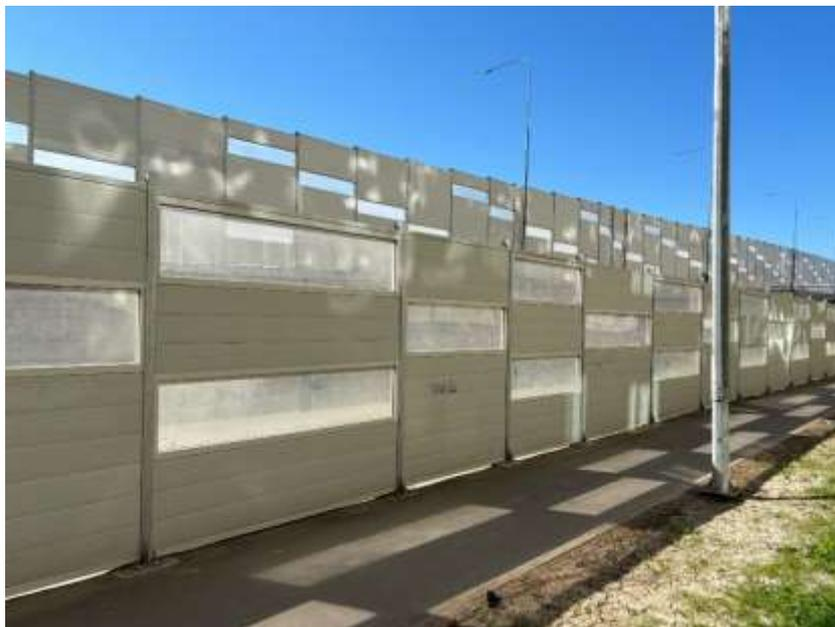
Рисунок 4.1 – Пример шумозащитного экрана на станции №44.
