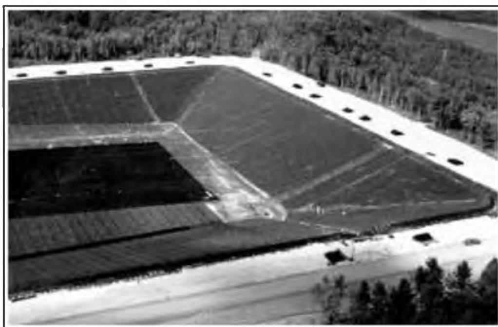
Рисунок 3.2 – Противофильтрационный экран из геосинтетического материала
