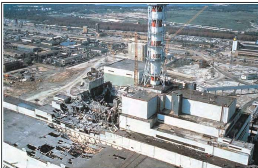
Рис. 4.3. Разрушенный после взрыва 4-й энергоблок Чернобыльской атомной электростанции.
