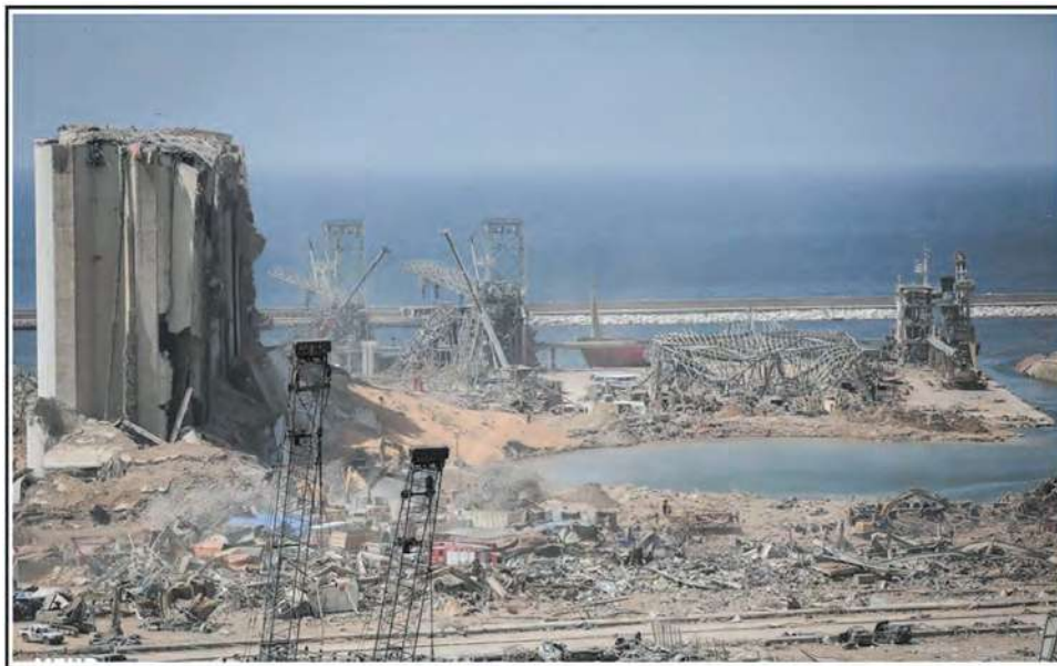
Рис. 4.12. Последствия мощного взрыва в порту Бейрута в 2020 г.
