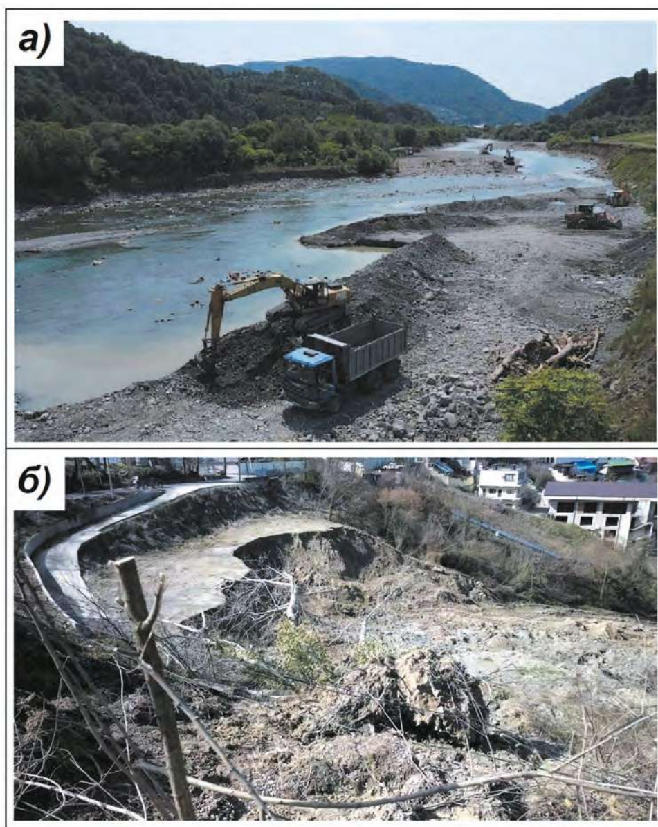
Рис. 7.23. Оползневые процессы в долине р. Мзымта в районе г. Сочи: а) эрозия береговой зоны; б) оползневые процессы в долине реки.
