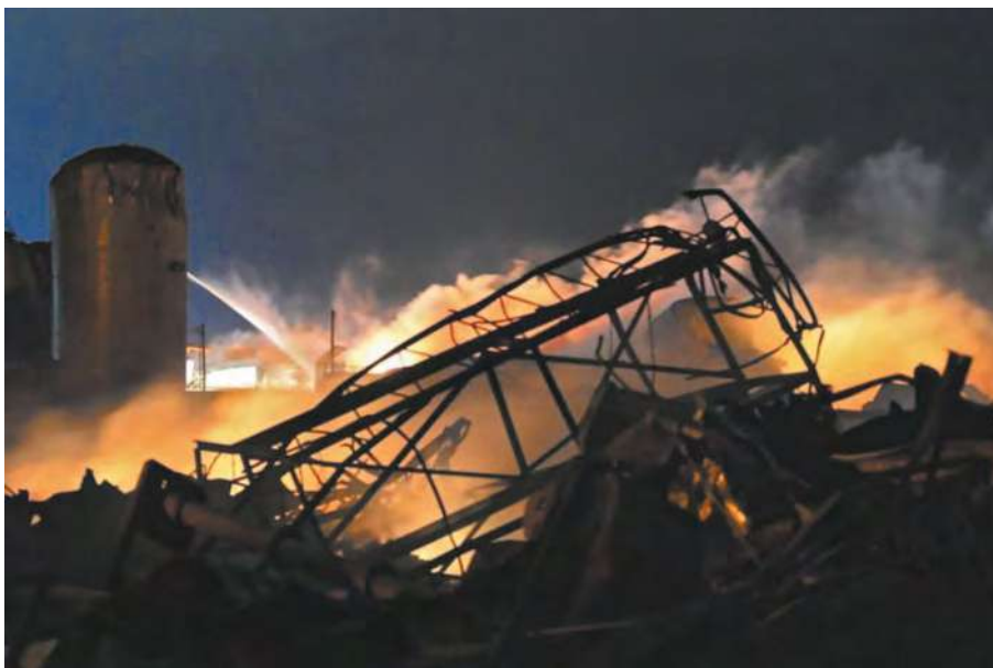
Рис. 4.9. Пожар на заводе по производству удобрений в городе Уэст, США, в 2013 г.
