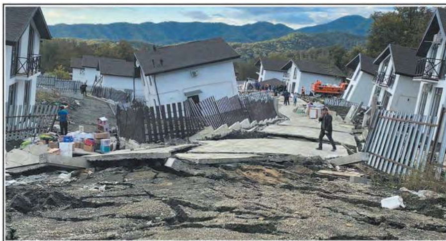
Рис. 7.22. Последствия оползня в коттеджном поселке «Горная поляна» в Лазаревском районе Сочи.
