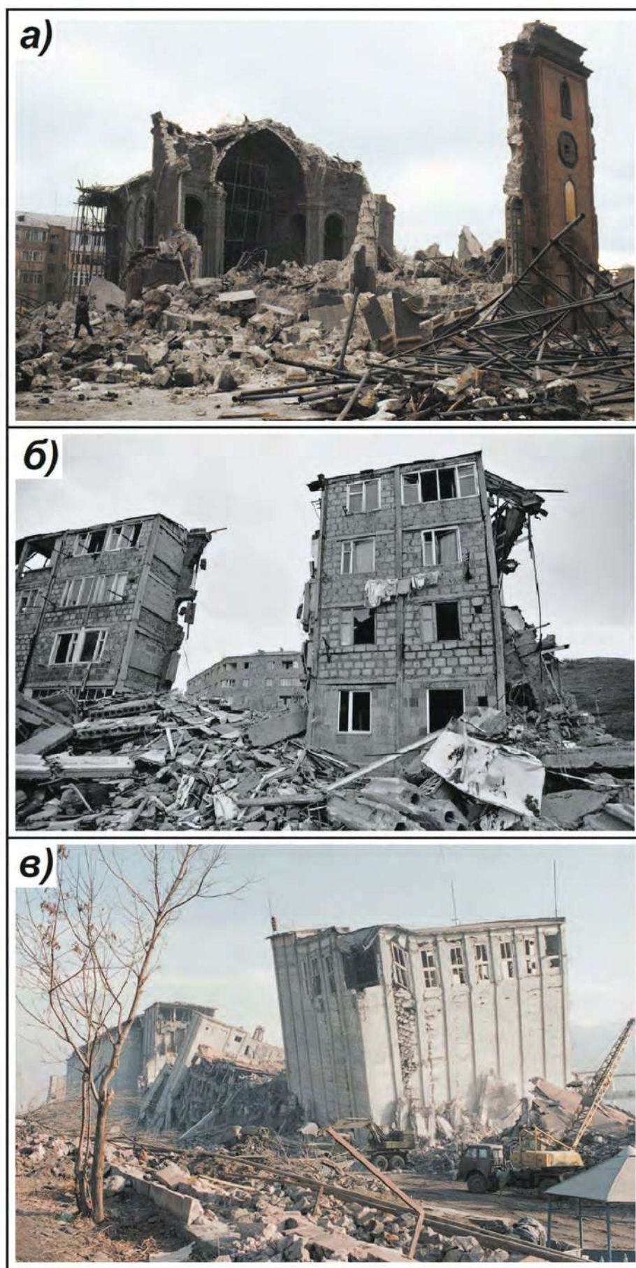
Рис. 6.8. Последствия землетрясения в Армении 1989 г., г. Спитак: а) разрушения в центре города; б) жилые здания; в) промышленные объекты.
