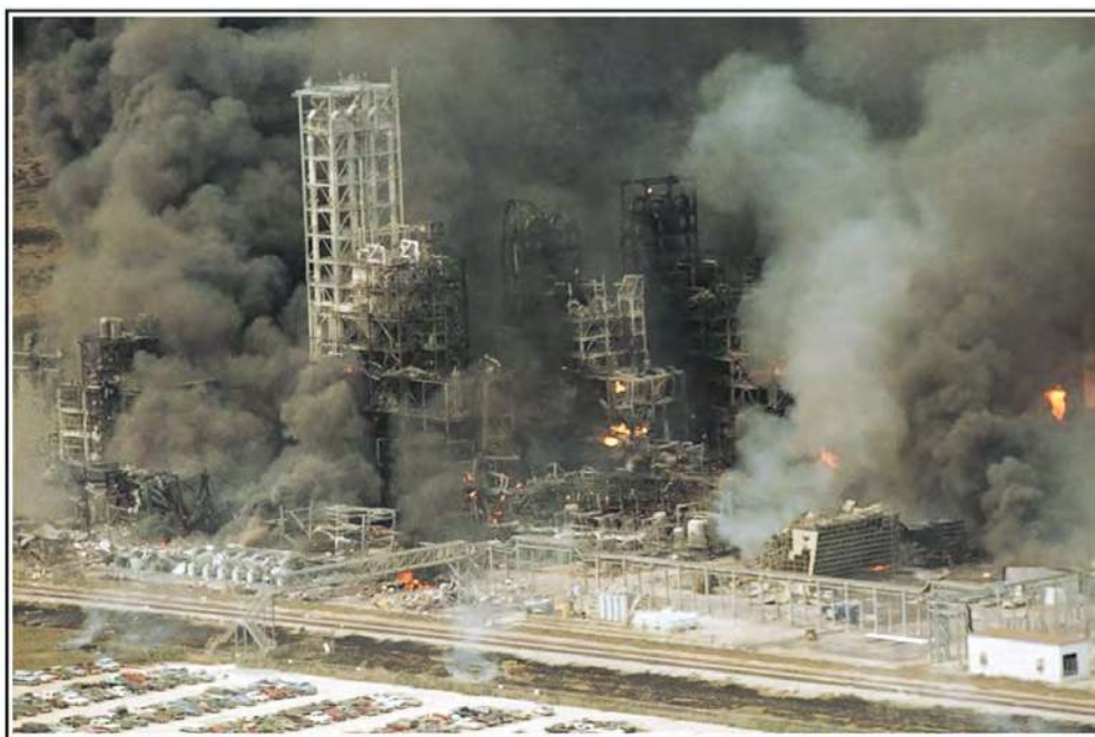
Рис. 4.6. Взрыв и пожар на химическом заводе Phillips в США в 1989 г.
