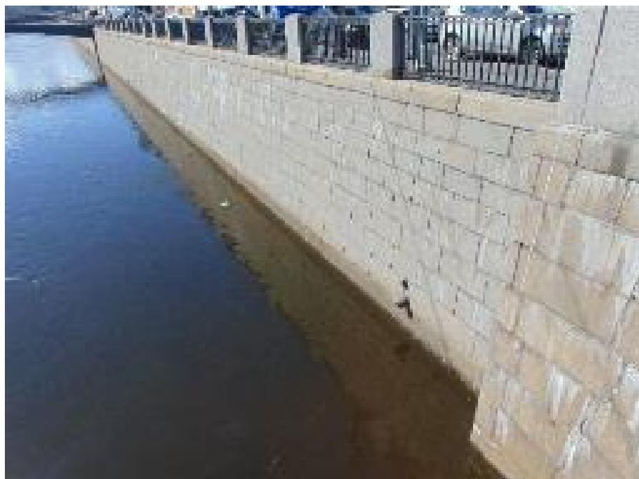
Рисунок 2.1.1 – Ливневые водоспуски в береговой стенке Обводного канала
