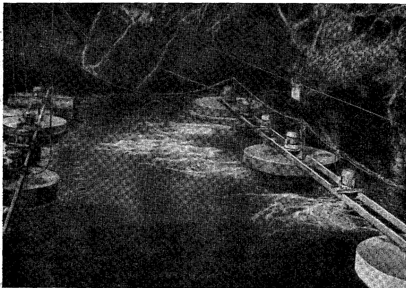
Рис. 9. Механическая аэрация речной воды в реке Невежис, Литовская ССР.
