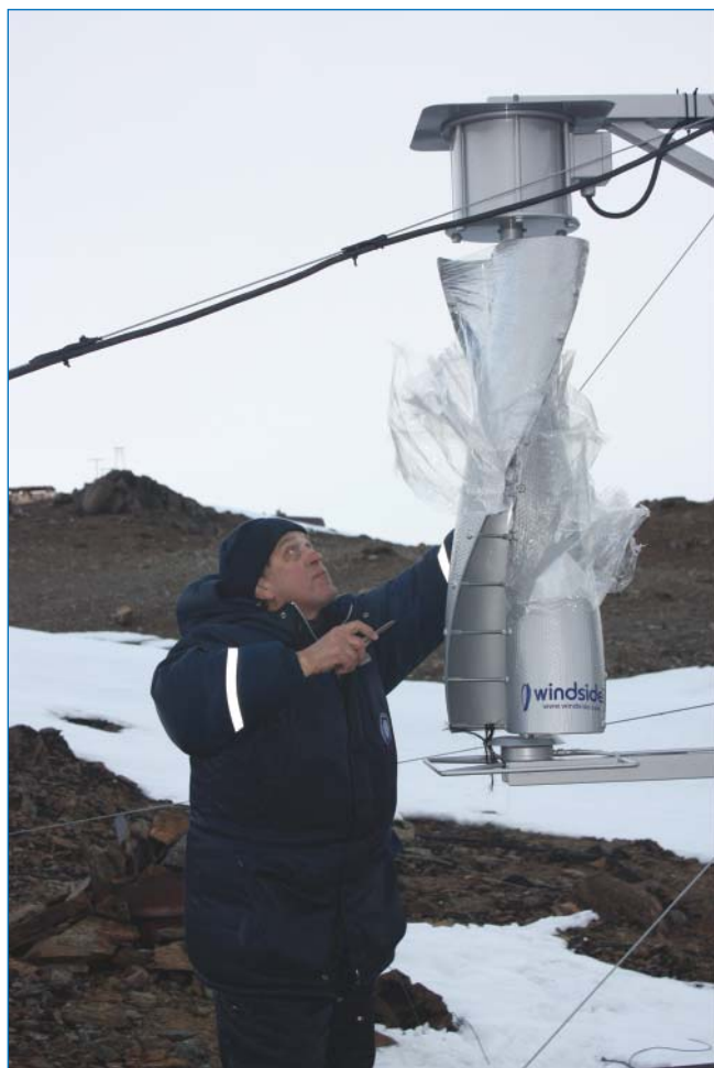
Установка ветрогенератора для автоматической метеостанции Русская
