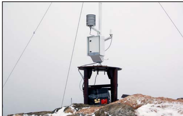
Крепление мачты и размещение аккумуляторов питания
